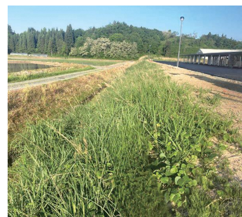
防草マット設置前
